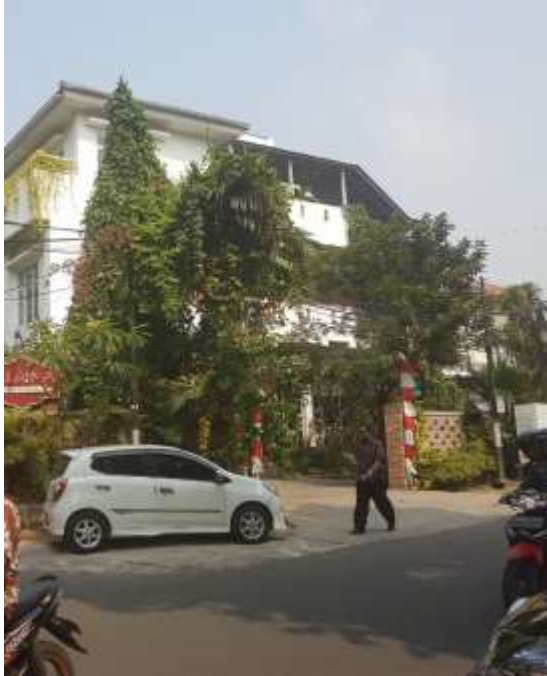
Gambar 14. Tidak adanya pembatas jalan di kawasan sekitar Pasar Santa (Dokumen pribadi, 2019)
