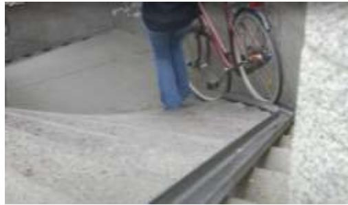
**Gambar 18. Rail Sepeda di Tangga**
