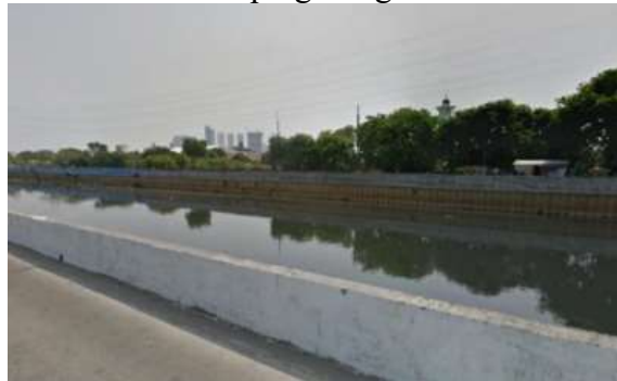
Gambar 41. Kondisi Tata Ruang Streetscape (Dokumentasi Pribadi, 2017)
