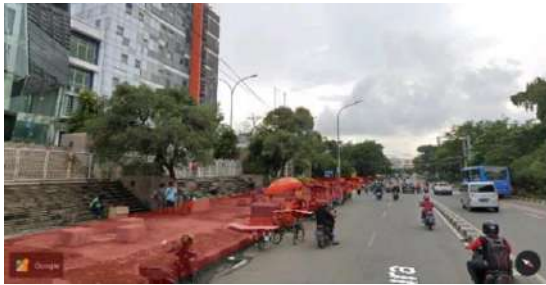
Gambar 13. Detail area perbaikan trotoar di Kawasan Mangga Dua (Mangga Dua, Google Earth, 2021)
