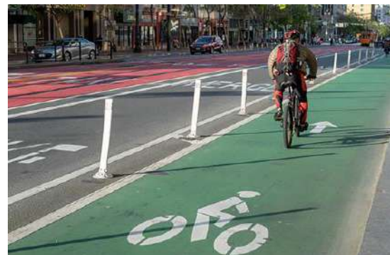
Gambar 32. Jalur sepeda di sertai dengan bollard di United States (Jalur sepeda United States, Google, 2021)
