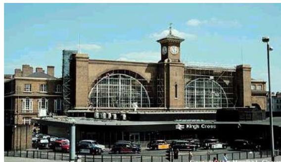
**Gambar 2.** Stasiun KA Kings Cross, London. Produk desain perbaikan transportasi kota industri. Tampak tipologinya sudah menggunakan baja tapi masih dikombinasikan dengan *masonry*. (Sumber : [www.washington.edu](http://www.washington.edu))
