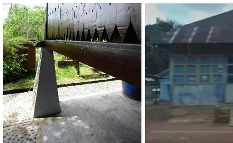
**Gambar 12. Fondasi setempat dan Fondasi Lajur**
